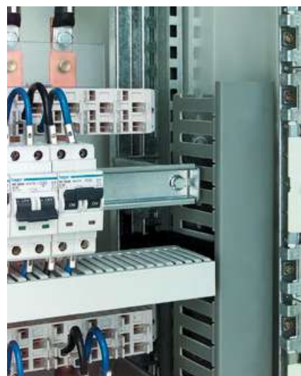
▲ Fissaggio delle canaline orizzontali verticali con supporti ad innesto
