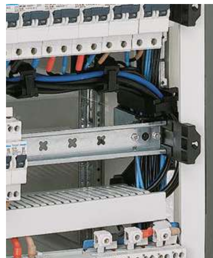
▲ Fissaggio dei cinturini guidafili con supporti ad innesto
